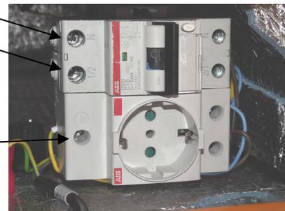
Назначение клемм автоматического выключателя кассы.
